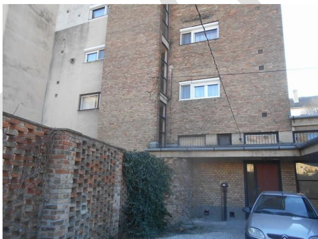
Az ingatlan udvar felőli, keleti homlokzata
