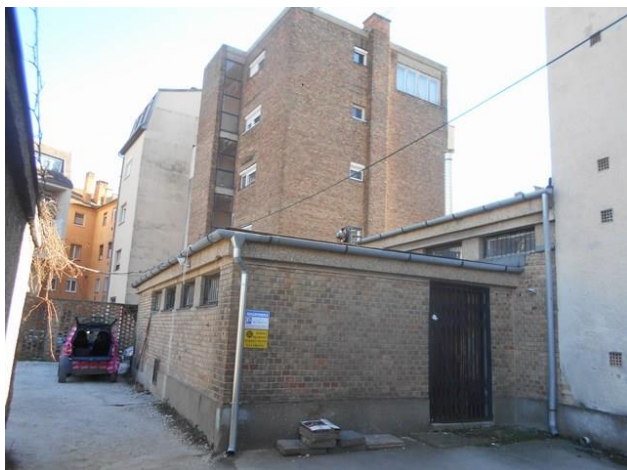
Bejárat az udvarra, az üzlet északi homlokzata
