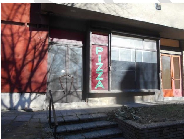
Az ingatlan (hrsz. 3888/8/A/10 bejárata
